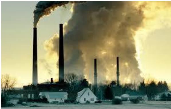
Usina de energia produzida com carvão mineral
